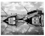
Fig. 1. Destruction of gas tank due to floods in Ostrava in 1997 [1] Rys. 1. Zniszczenie zbiornika gazu z powodu powodzi w Ostrawie w 1997 r. [1]
