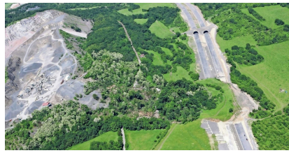
Fig. 7. The 2013 landslide at its largest extent. The thin silvery line represents the damaged and still non-functional railway line [20] Rys. 7. Osuwisko w 2013 roku. Cienka srebrzysta linia przedstawia uszkodzoną i wciąż nieczynną linię kolejową [20]
